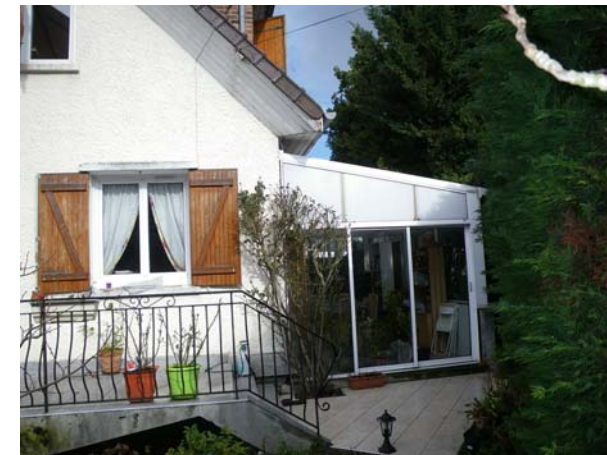
Visuel de près avant travaux
