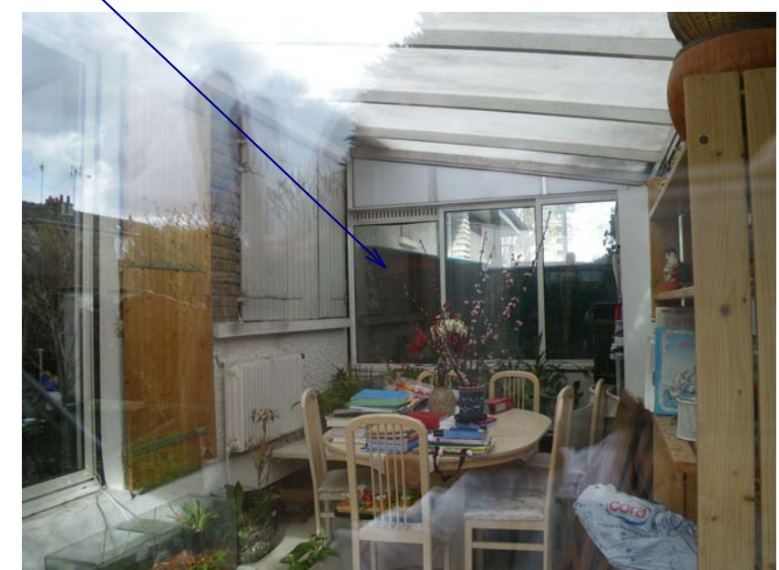
DP 7 - Véranda de l'intérieur
